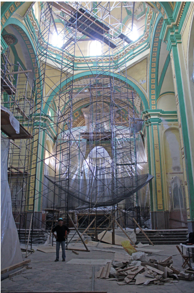
Vista del interior del templo, mostrando parte del proceso de restauración Parroquia de San José, Tlaxcala.
