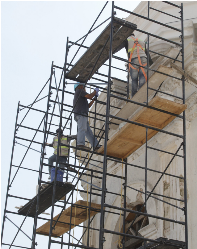
Trabajos de consolidación en torre campanario, Parroquia de San José, Tlaxcala.
