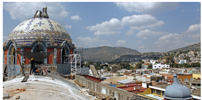
Vista de extradós de bóveda y cúpula principal en su proceso de restauración, Parroquia de San José, Tlaxcala.
