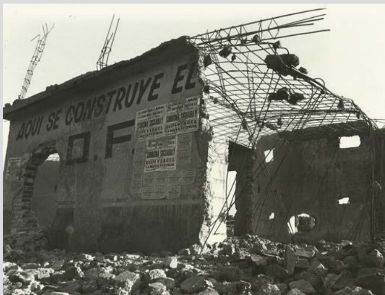
Foto de Rebeca Monroy Nasr, Aquí se construye el D.F. Enero 1981.
