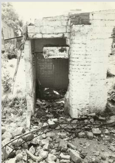
Foto de Rebeca Monroy Nasr, Aquí se construye el D.F. Enero 1981.
