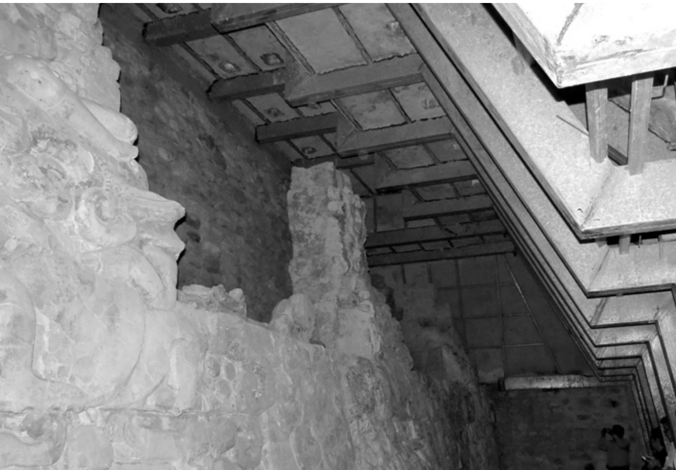
FIGURA 11. BALAM KU Oxidación de los elementos de la cubierta del friso en la zona arqueológica Imagen de la autora.
