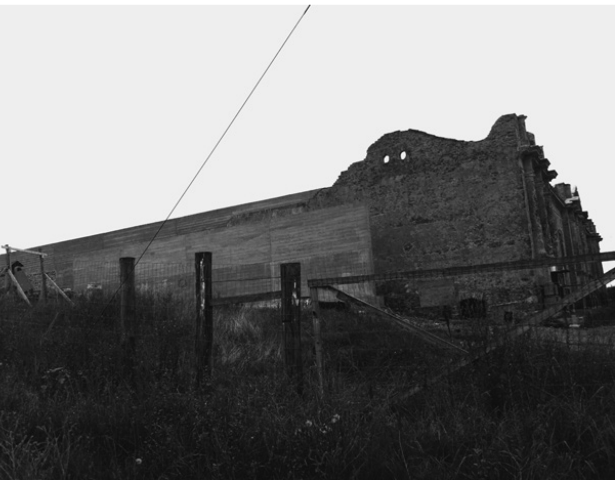
Figura 5. Enfermaria de Jaguarão aparecendo a intervenção em concreto armado. Imagem do autor.
