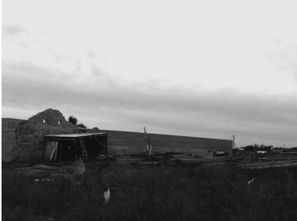
Figura 6. Enfermaria de Jaguarão aparecendo a extensa cortina de concreto. Imagen do autor.
