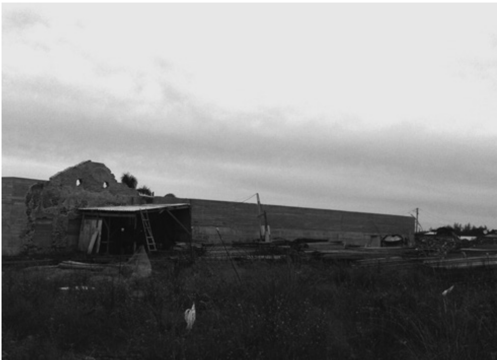
Figura 6. Enfermería de Jaguarão en donde se ve la extensa cortina de concreto armado. Imagen del autor.
