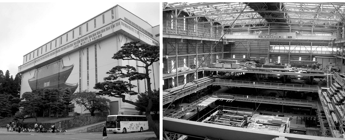
FIGURA 3. EL TEMPLO RINNŌJI, NIKKO, TOTALMENTE DESMONTADO PARA SU RESTAURACIÓN, 2014. Imagen: José Miguel Silva.
