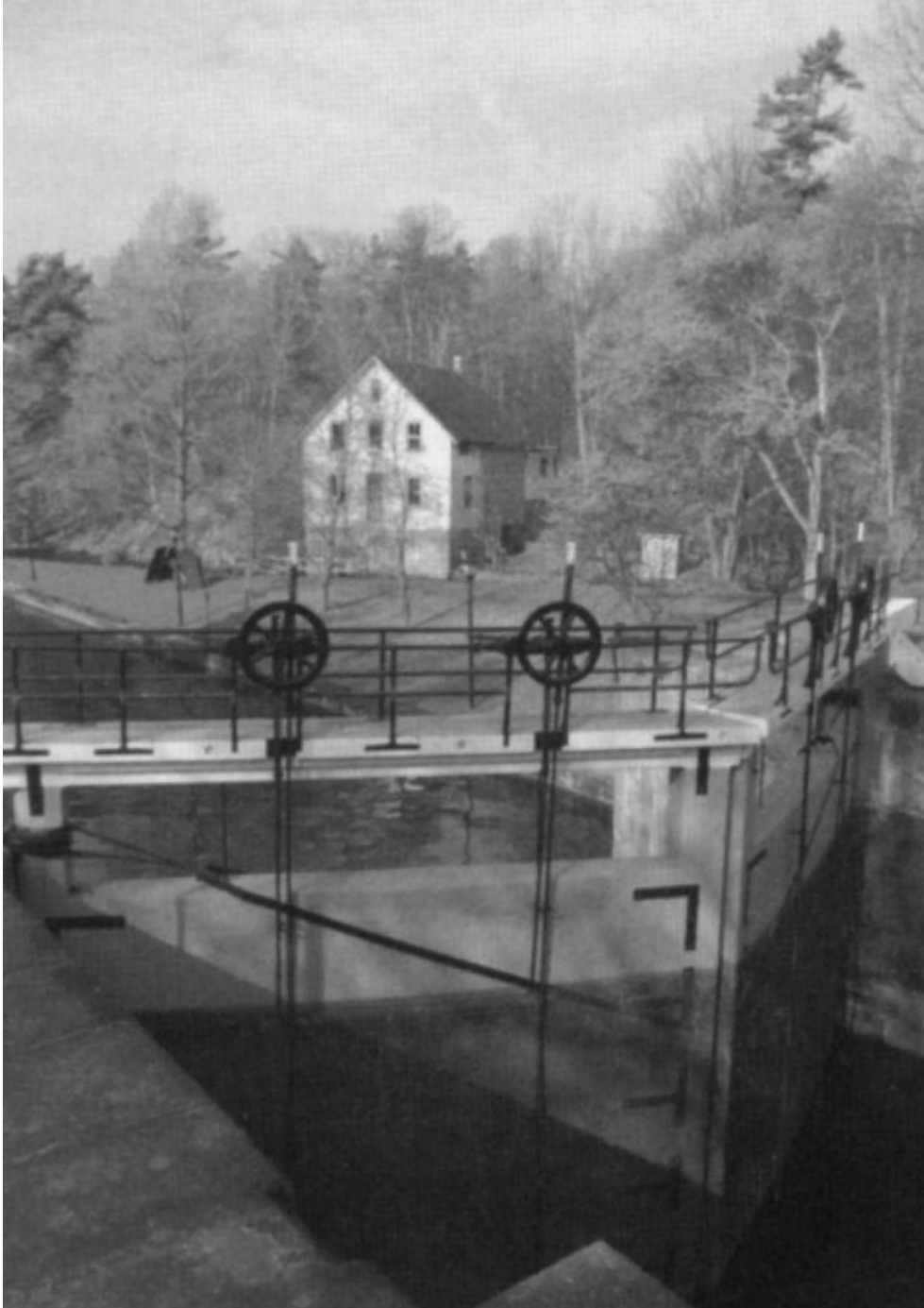
CANAL RIDEAU. La autenticidad de los canales en funcionamiento en el Canal Rideau, un canal histórico canadiense inscrito en la Lista de Patrimonio Mundial en 2007, se basa en la conservación de las formas originales de diseño más que del material de madera original, ahora deteriorado y reemplazado muchas veces. Imagen: Herb Stovel.
