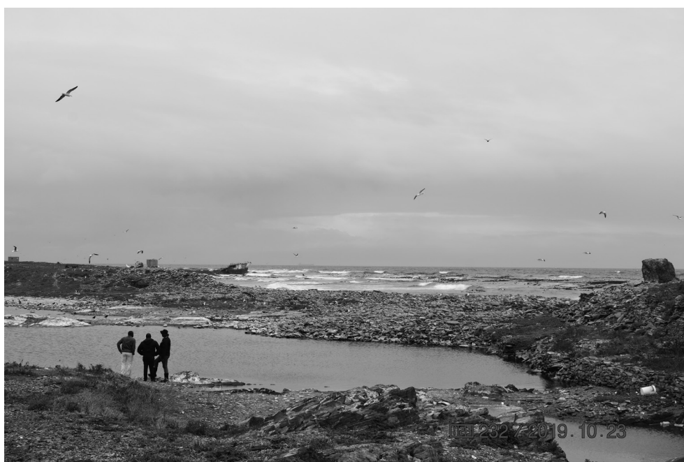
SITIO DE LA CANTERA BLUE STONE. Colapso progresivo del muro. Imagen: ©Pascall Taruvinga, 2019.
