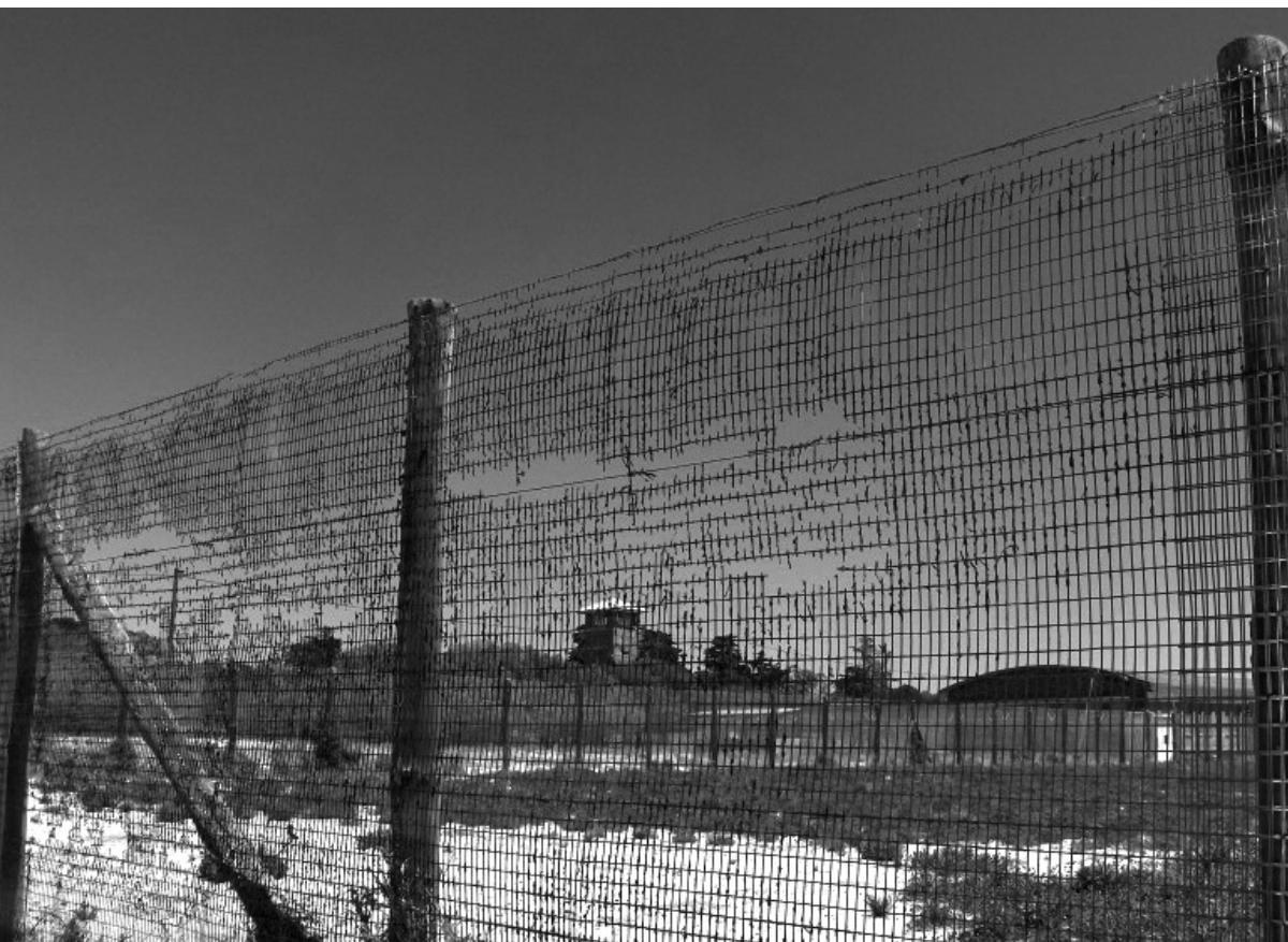
PRISIÓN DE MÁXIMA SEGURIDAD. Barda eliminada durante los trabajos de mantenimiento. Imagen: ©Pascall Taruvinga, 2019.
