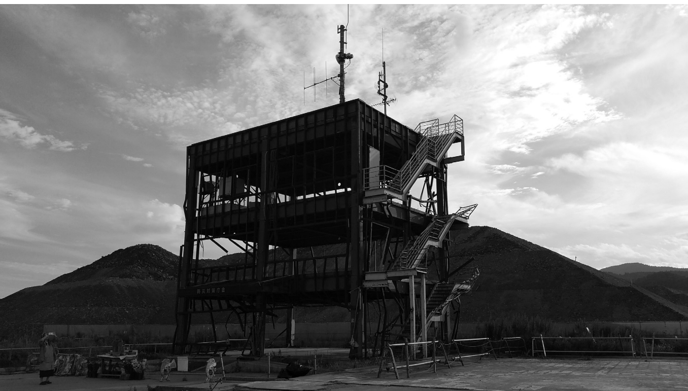
SHIZUGAWA, JAPÓN. El esqueleto del centro de prevención de desastres, ubicado en el centro de la ciudad de Shizugawa, después de los daños masivos causados por el gran tsunami de 2011 en el este de Japón, se ha convertido en un lugar popular para los visitantes. Imagen: Rohit Jigyasu.
