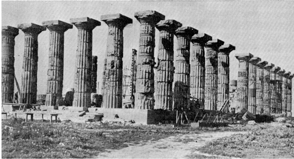
FIGURA 3. RESTAURACIÓN DEL TEMPLO E DE SELINUNTE POR NAPOLEONE GANDOLFO. Documentación y vistas antes y después de la intervención. Imagen: Dezzi Bardeschi e Sanpaolesi (1964: np).
