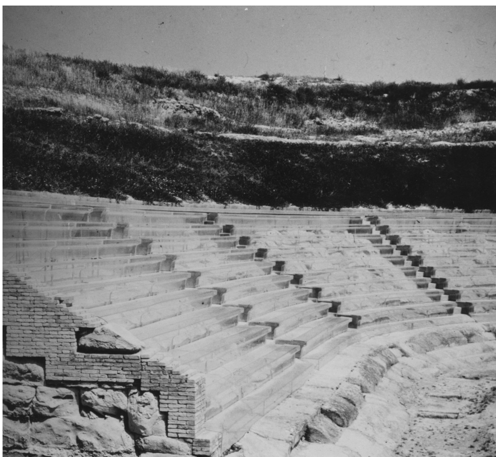
FIGURA 1. CÁVEA DEL TEATRO HELENÍSTICO DE HERACLEA MINOA. Restauración mediante el uso de resina sintética por Franco Minissi. Imagen: ©ICCROM.
