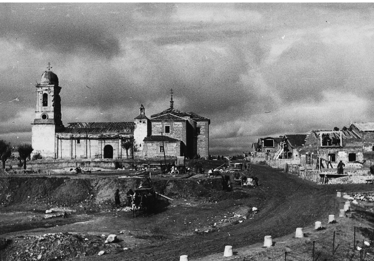
FIGURA 7. BRUNETE. VISTA GENERAL CON LAS RUINAS ELIMINADAS, LA IGLESIA SIN RECONSTRUIR Y LA CONSTRUCCIÓN DE LAS PRIMERAS CASAS, 1940. Imagen: Colección privada.
