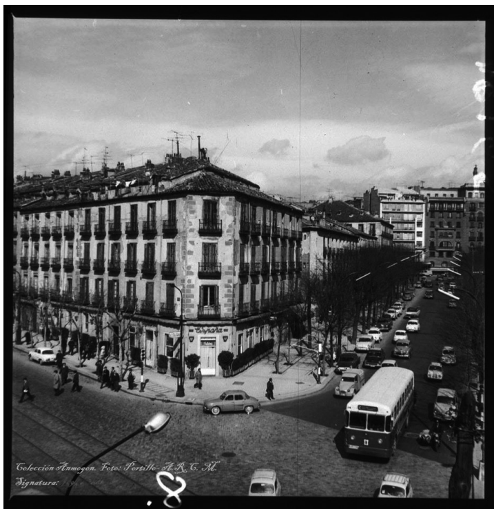
FIGURA 3A. VISTA DE LA CALLE PRINCESA CON ALBERTO AGUILERA, EN EL BARRIO DE LAS POZAS, MADRID, ANTES DE SU DESTRUCCIÓN, 1969. Imagen: Colección Anmagon, Archivo Regional de la Comunidad de Madrid, Fondo Portillo, signatura 75946-013.
