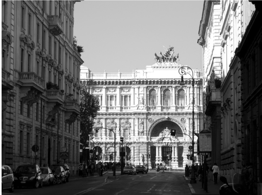
PALAZZIO DI GIUSTIZIA, ROMA. Veduta da via Zanardelli. Immagine: Andrea Pane, 2007.
