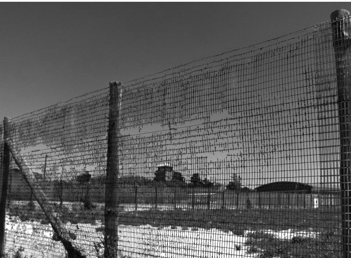
PRISIÓN DE MÁXIMA SEGURIDAD. Barda eliminada durante los trabajos de mantenimiento. Imagen: ©Pascall Taruvinga, 2019.
