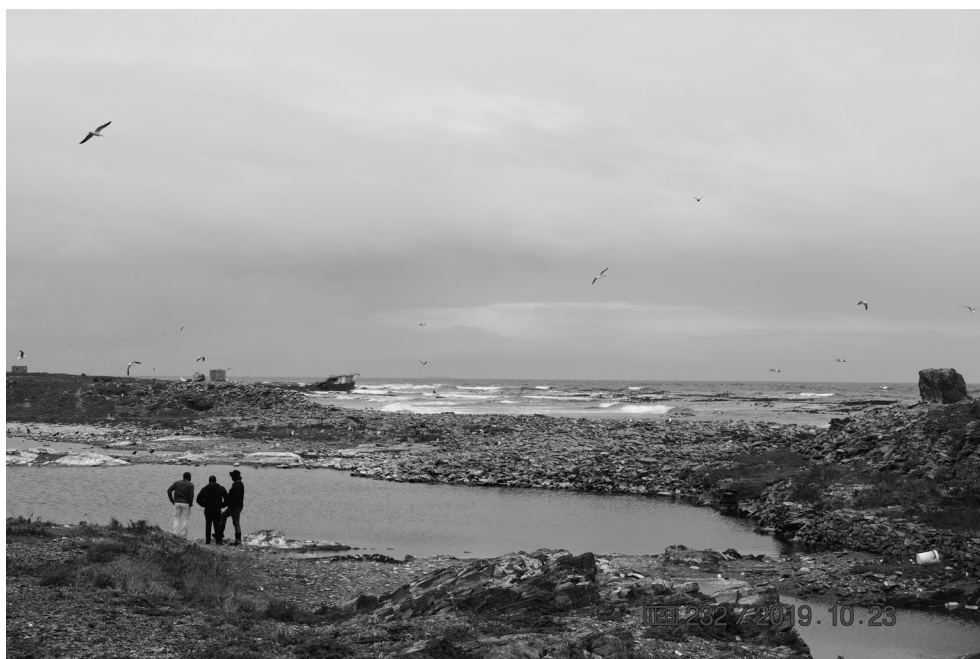
SITIO DE LA CANTERA BLUE STONE. Colapso progresivo del muro. Imagen: ©Pascall Taruvinga, 2019.
