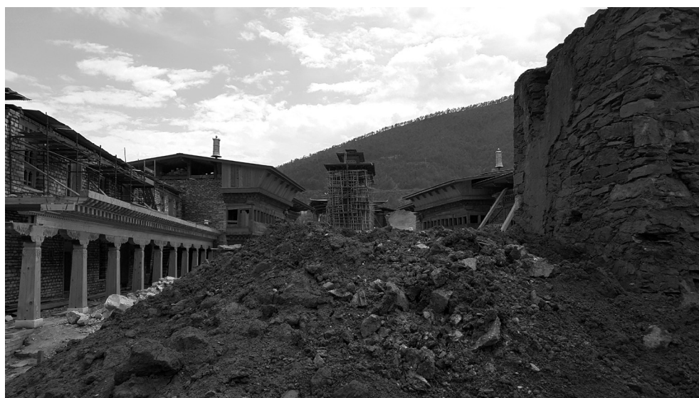
WANGDUAPHODRANG ZHONG, BHUTAN. Reconstrucción realizada después del incendio devastador de 2012, con la participación de artesanos locales. Imagen: Rohit Jigyasu.
