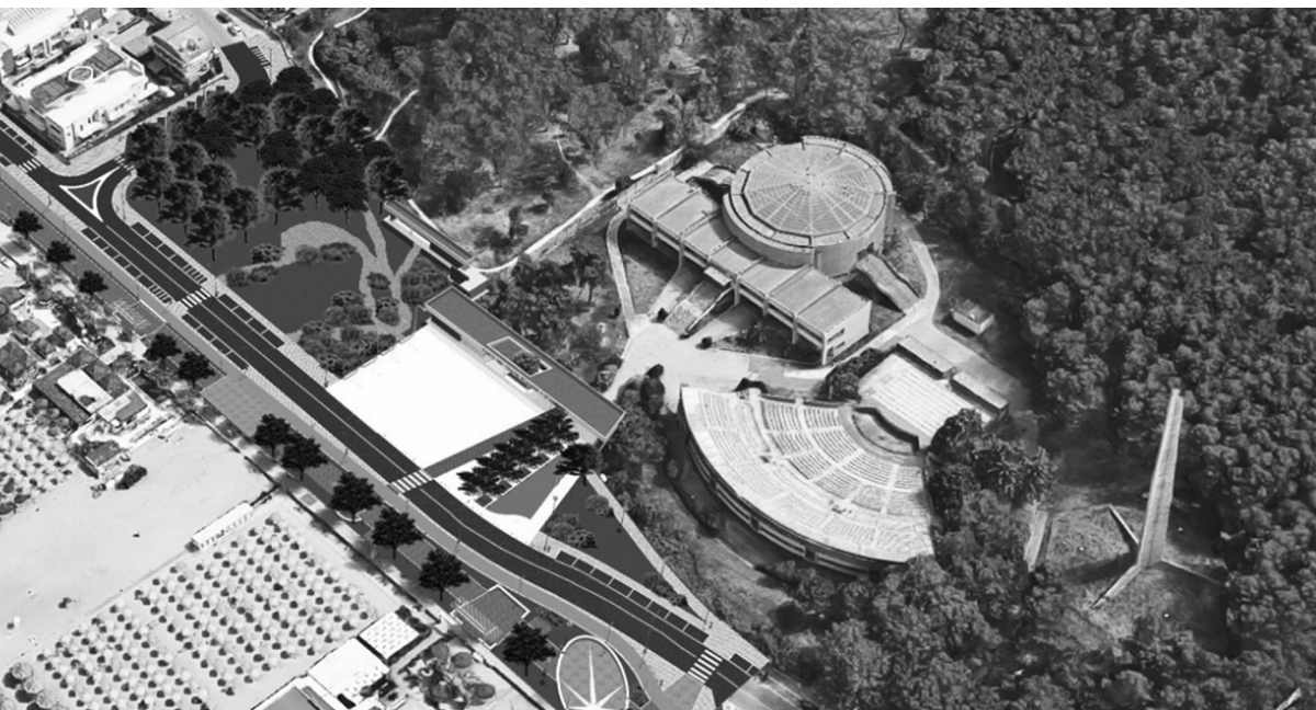
FIGURA 10. VISTA GENERAL DEL COMPLEJO ARQUITECTÓNICO CON EL TEATRO AL AIRE LIBRE, EL AUDITORIO Y LA ESTELA, DESDE EL MUNICIPIO DE PESCARA. Imagen: Progetto di riqualificazione del lungomare sud, 2019.
