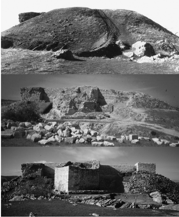
FIGURA 9. ALARCOS. TORRE PENTAGONAL EN LA PROA DEL CASTILLO DE ALARCOS.
