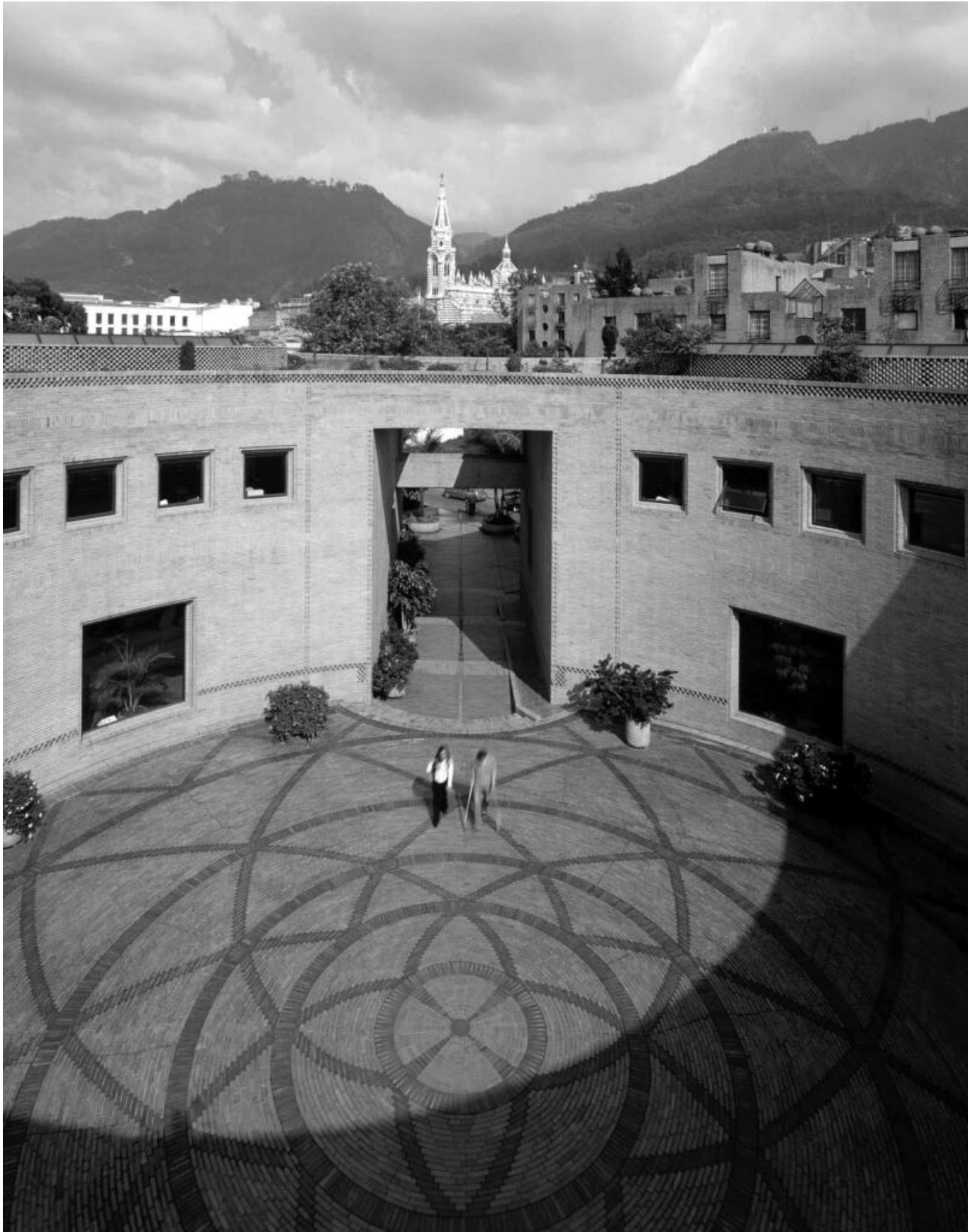
EDIFICIO DEL ARCHIVO GENERAL DE LA NACIÓN, COLOMBIA. Rogelio Salmona, 1992. Imagen: Dominio público.
