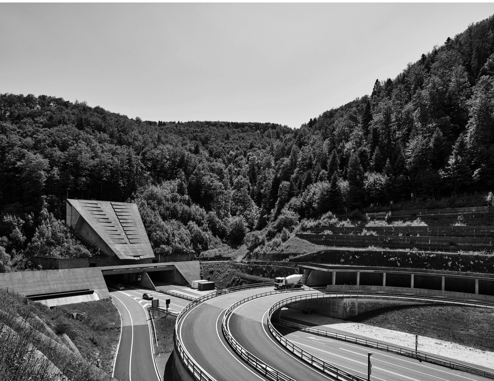
IM BILD EIN STRECKENABSCHNITT DER A16 TRANSJURANE. Bild: ©BAK / Rolf Siegenthaler.
