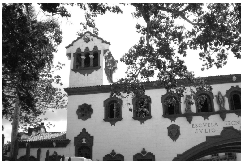
FIGURA 4. ARQUITECTURA NEOCOLONIAL EN LA HABANA. Instituto Técnico Industrial, Govantes y Cabarrocas, 1929. Imagen: Ángela Rojas.
