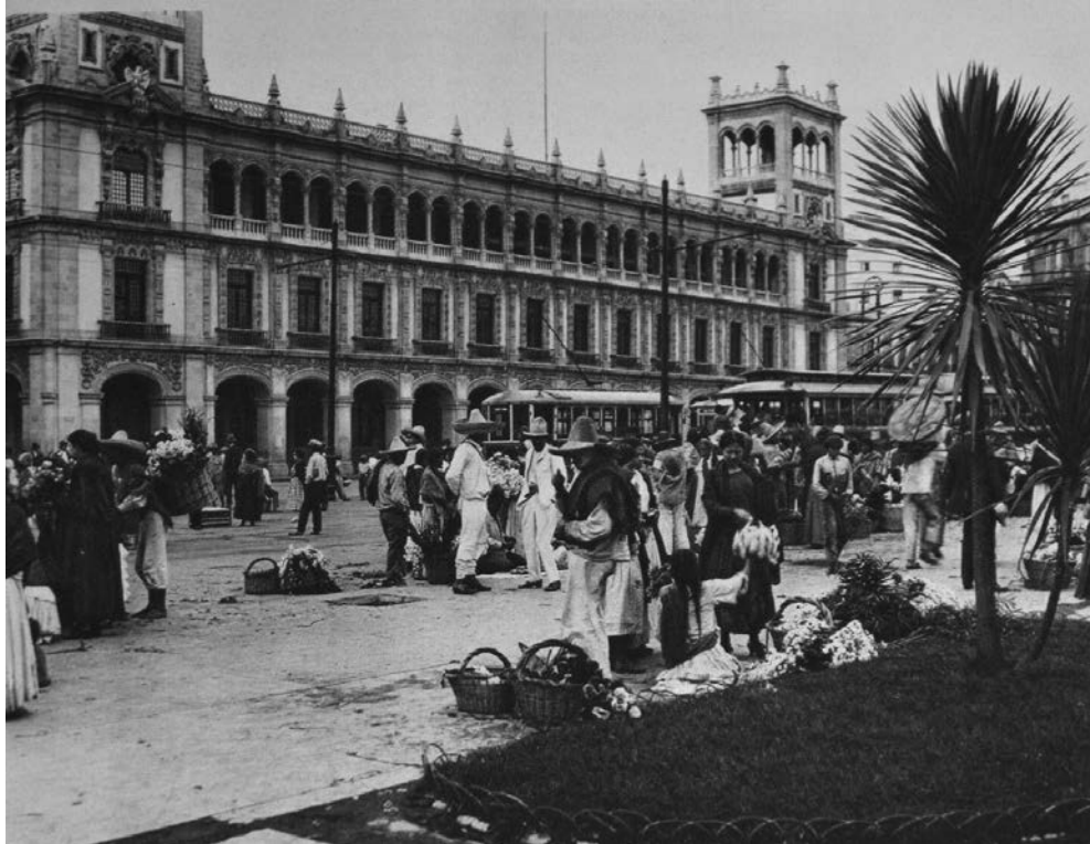
AYUNTAMIENTO, CIUDAD DE MÉXICO, CA. 1923. Antes de que se modificara el edificio, y antes de que se abriera la avenida 20 de noviembre. Imagen: Dominio público.
