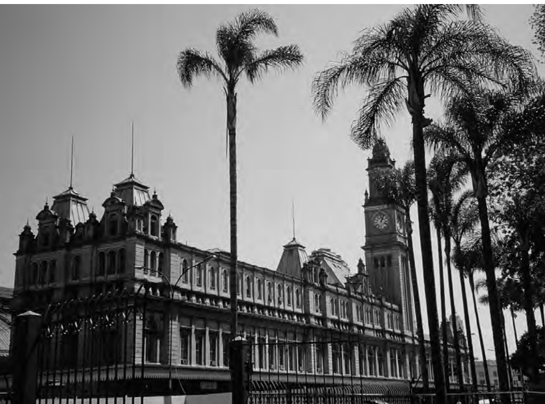
ESTACIÓN DE LUZ . Ciudad de Sao Paulo (Brasil). Antes de la intervención, 2001. Imagen de la autora.
