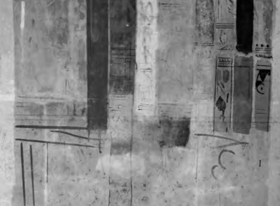
FIGURE 5. PIERREFONDS Nuancier exécuté sur un mur intérieur du château. Image: © A. Timbert.
