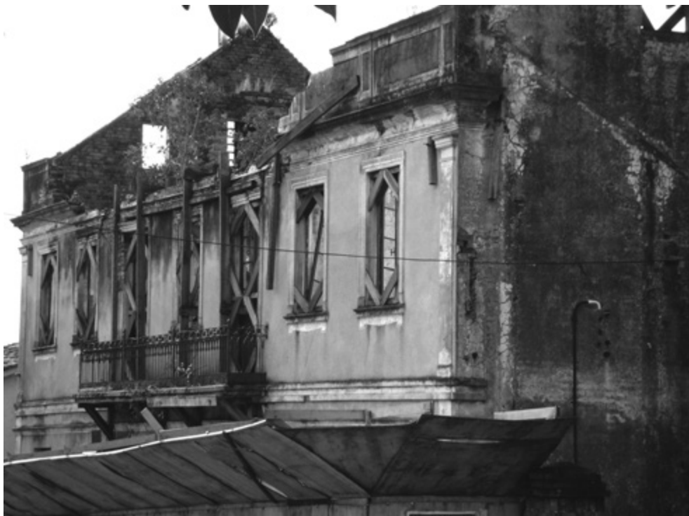
Figura 1. Lar das meninas, fachada antes da restauração. Imagem do autor.
