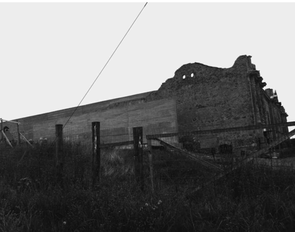
Figura 5. Enfermaria de Jaguarão aparecendo a intervenção em concreto armado. Imagen do autor.
