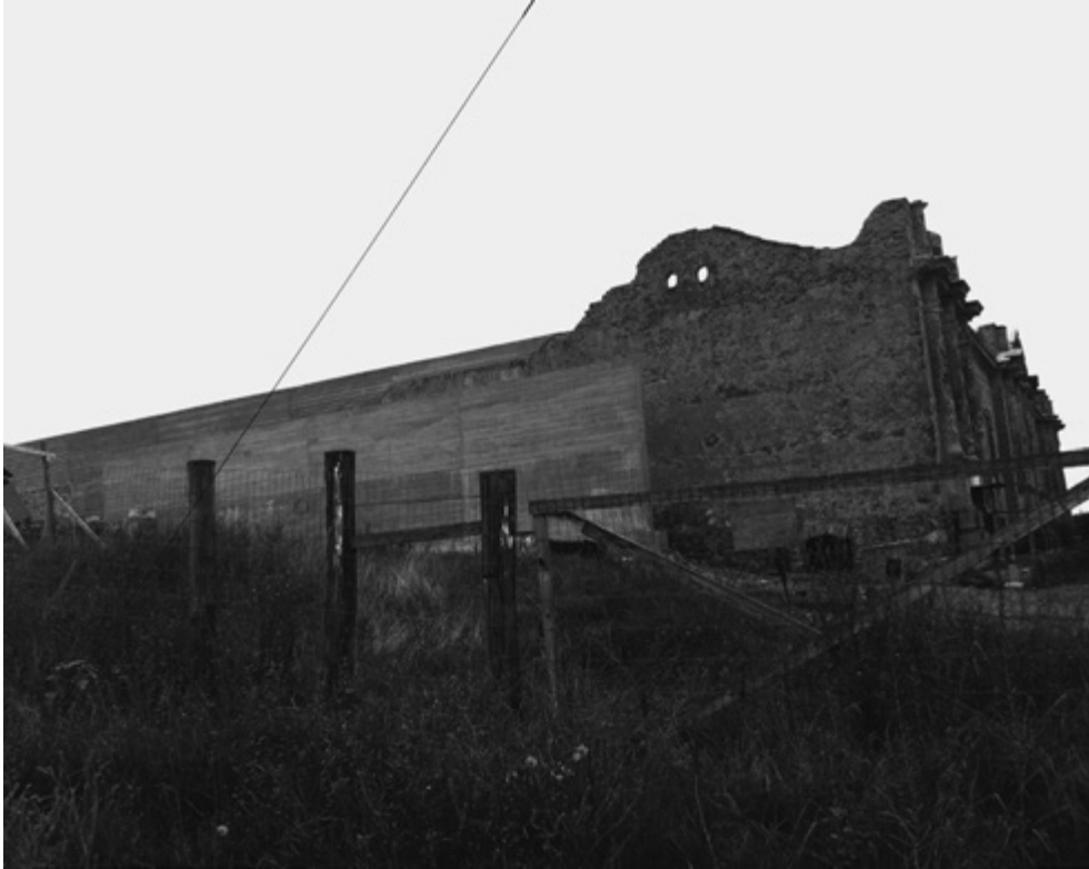
Figura 5. Enfermería de Jaguarão en donde se ve la intervención en hormigón armado. Imagen del autor.
