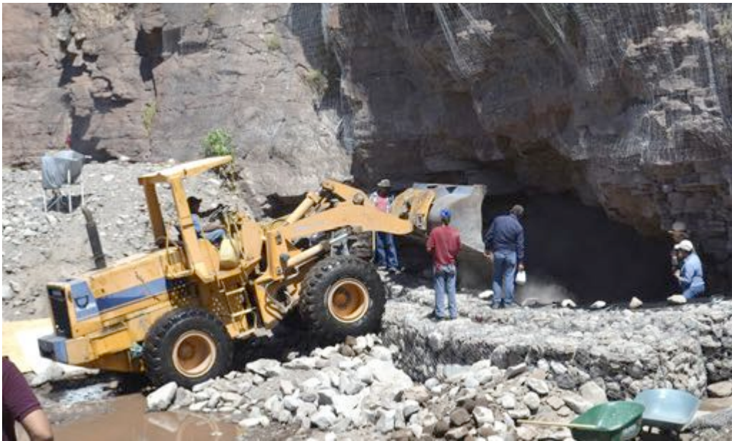
Figura 14. Depósito del relleno de granulometría gruesa en el sistema de reenterramiento confinado por gaviones. Imagen: Angélica Vásquez Martínez, ©CNCPC-INAH, 2016.
