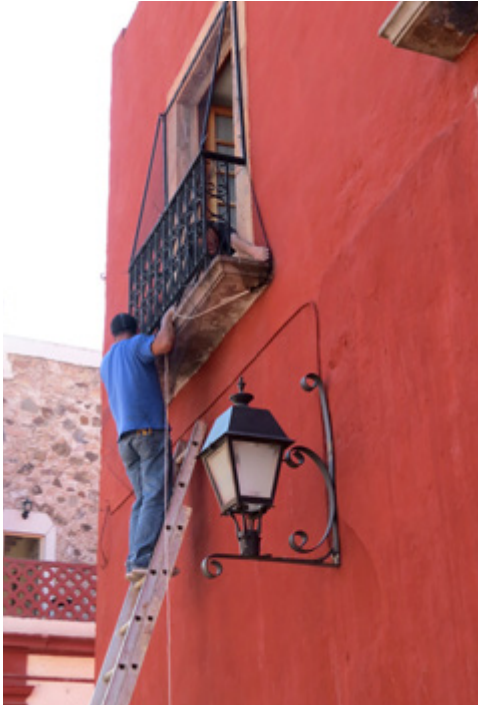
Figura 2. Fijado de la malla antipájaro en uno de los balcones de la Sala 4 de la Biblioteca Histórica. Imagen: Rosario Bravo, ©INAH.
