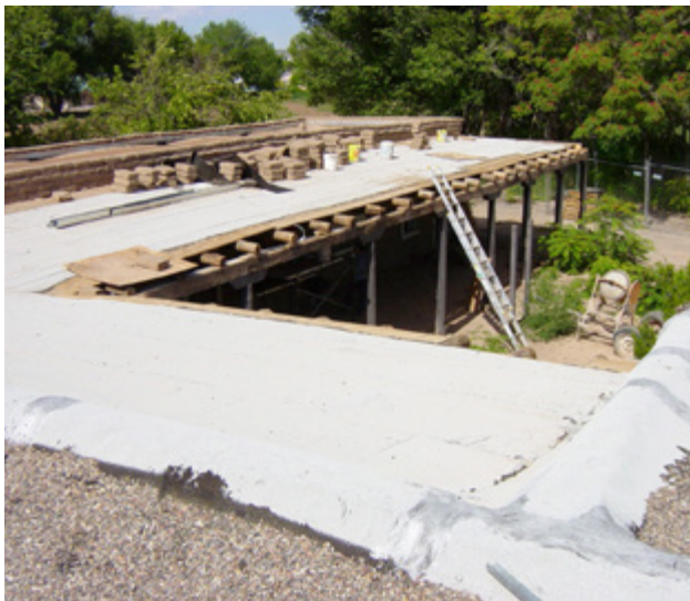
▲ Figura 3. Sistema certificado de cubierta a base de membranas plásticas aislantes, usado para la restauración de la Gutierrez-Hubbell House en Bernalillo, New Mexico, inmueble histórico de adobe que originalmente tuvo techos de terrado. Foto: Luis Fernando Guerrero Baca.
