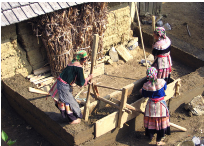
◀ Figura 3. Construcción con tierra en el norte de Vietnam. Foto: Alfred Boc.
