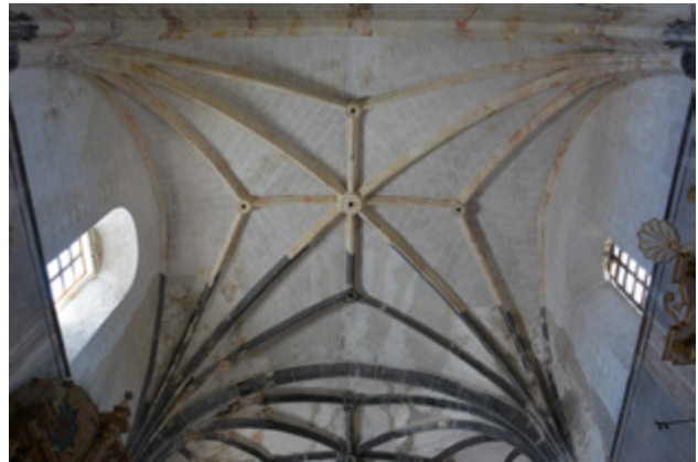
▲ Vista del avance de la intervención de la bóveda del templo | Foto: © Acervo CNCPC-INAH, 2016.
