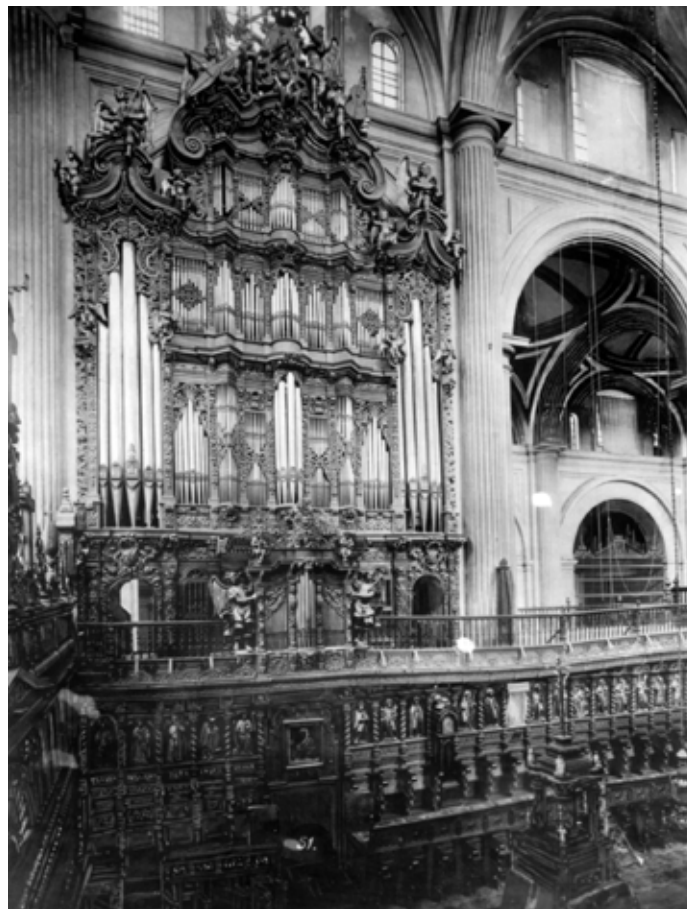
▲ Fachada interior del órgano oriente, llamado de la Epístola, antes del incendio. Álbum 1. Foto. LXXXIII-85. Fototeca CNCPC | © INAH, s.f.
