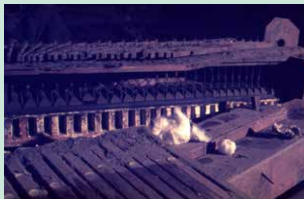
▲ Detalle de una caja de válvulas de los órganos. Álbum 4. Foto. LXVI/17-4-3. Fototeca CNCPC | © INAH, 1975.
