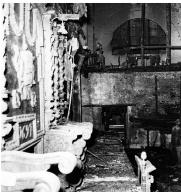
▲ Interior del coro después del incendio. Álbum 1. Foto. DXLV-2. Fototeca CNCPC | © INAH, s.f.
