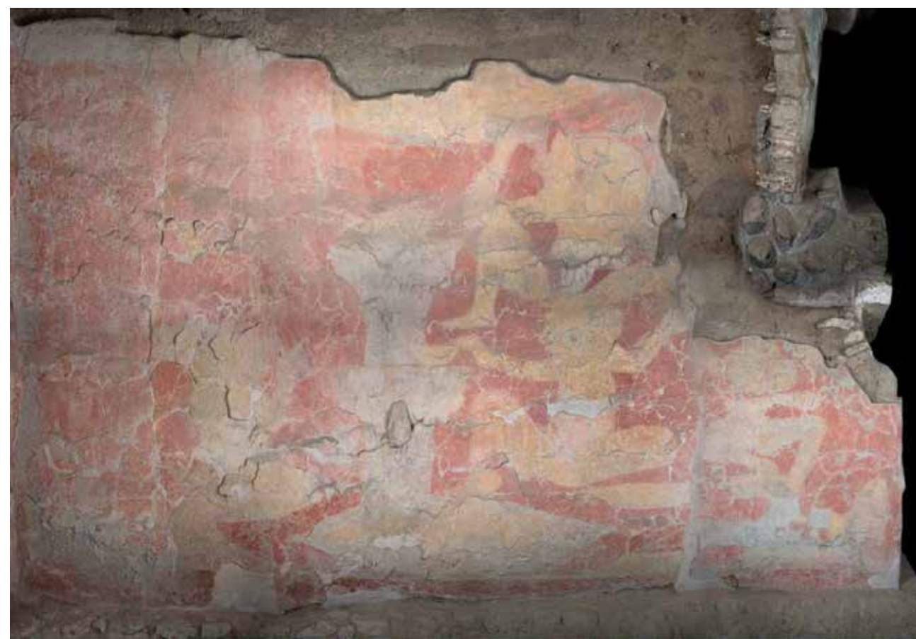
▼ Lámina 2. Fotografía y dibujo del muro 2. CNCPC | © INAH, 2015.
