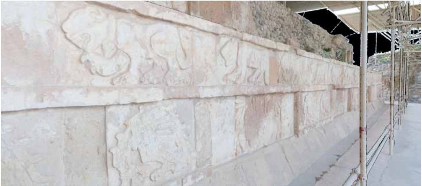
▲ Figura 6. Vista perspectiva de la Fachada Este en nube de puntos con fotografía integrada. CNCPC | © INAH, 2015.
