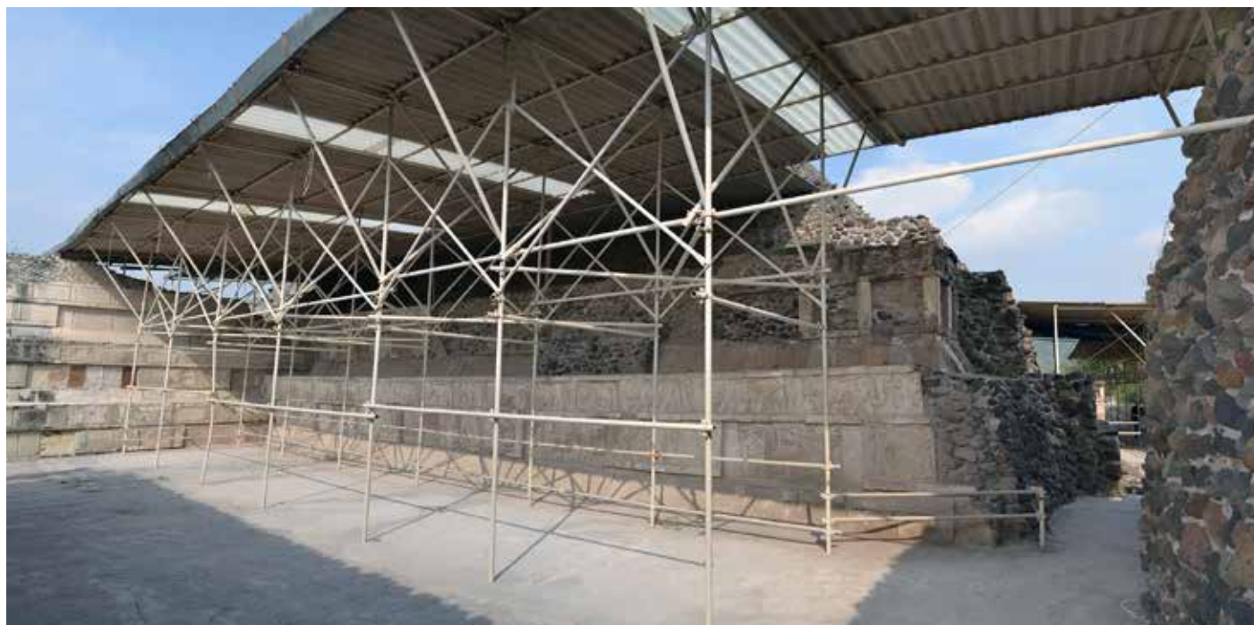
▲ Figura 1. Vista general de la Fachada Este de la Estructura B. CNCPC | © INAH, 2015.
