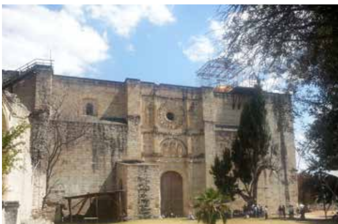
▲ Fig. 2 Reparaciones en contrafuertes y refuerzos añadidos. Fototeca CNCPC. | © INAH, 2014.
