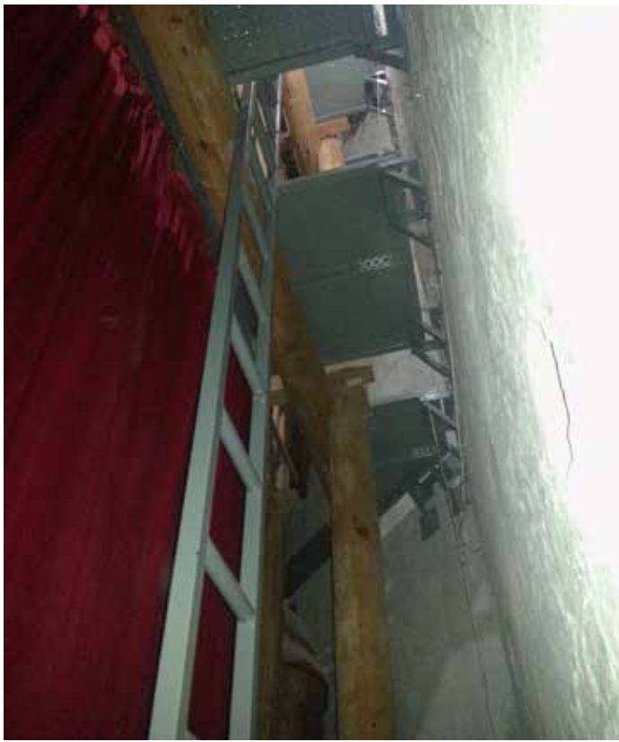
▲ Fig. 40 Estructura auxiliar añadida en la restauración tras el retablo de Coixtlahuaca. Fototeca CNCPC | © INAH, 2014.
