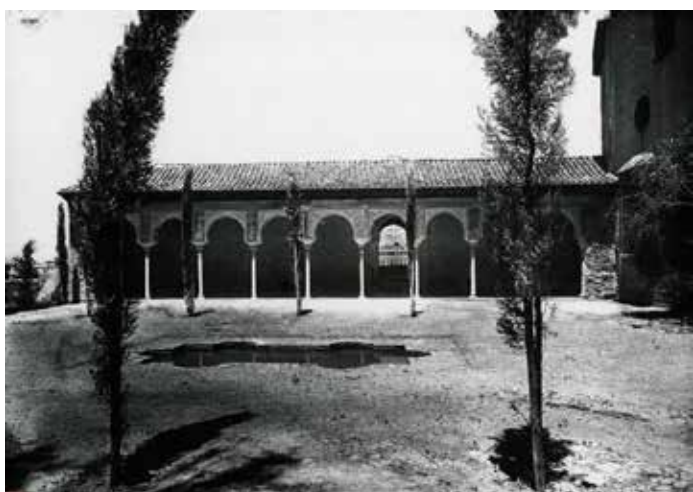
▲ Fig. 44 Vista del patio de Machuca restaurado, el patio tiene varios árboles sembrados. La línea de cipreses delante de la galería conservada es eliminada y sustituida por naranjos posteriormente por el propio Torres Balbás para evitar la distorsión visual. | © APAG/ Colección de Fotografías/ F-13011. R-3871.
