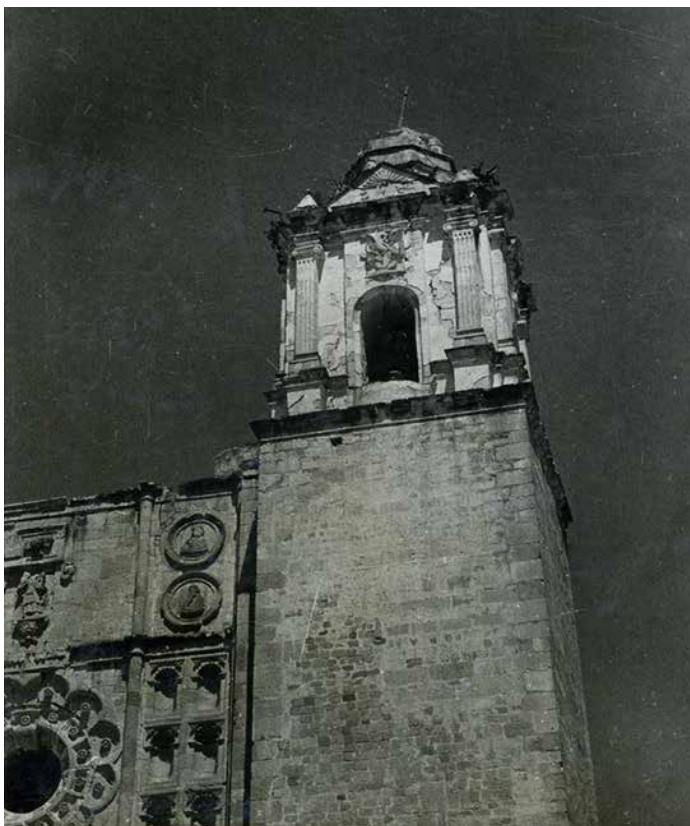
▲ Fig. 7 Fachada oeste de la torre antes de la restauración de 1957. CLX-53, V0A15TVII-A, CNMH | © INAH.
