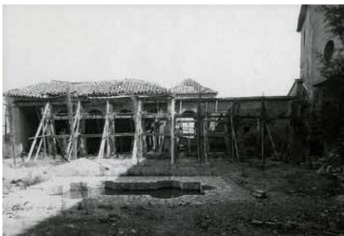
▲ Fig. 43 Vista del Patio de Machuca en obras, la pared y techumbre apuntalada con trancos de madera. | © APAG/ Colección de Fotografías/ F-13010. R-3870
