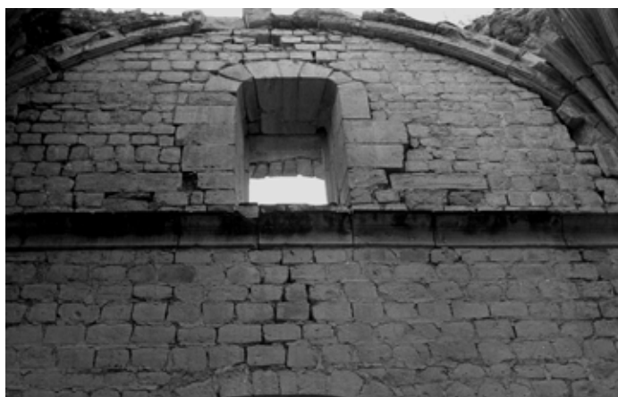
▲ Fig. 22 Lateral de la sacristía adyacente a la sacristía antes de la reconstrucción de la bóveda. COIXTLAHUACA_11A-3_1964-1969. XX-19-4-5. 23 junio 1965. J. Cama. Fototeca CNCPC | © INAH.
