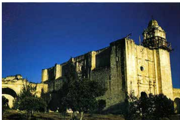
▲ Fig. 10 Estructura de colocación del zuncho de atado de la torre en 1957. | © VENCES, 2000: 250.
