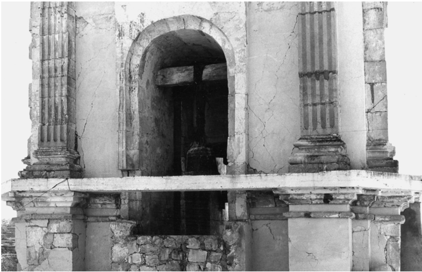
▲ Fig. 14 Zuncho de atado de la torre. COIXTLAHUACA_11A-1_1963-1969. X-13-5-5. Hacia 1964. Fototeca CNCPC | © INAH.
