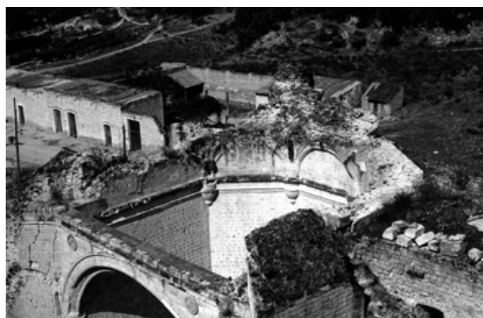
▲ Fig. 19 Zuncho de hormigón armado sobre el arco de la capilla abierta. COIXTLAHUACA_11A-1_1963-1969. X-13-3-5. Hacia 1964. Fototeca CNCPC | © INAH.
