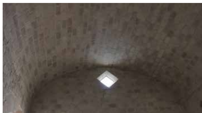
▲ Fig. 30 Bóveda reconstruida. Fototeca CNCPC | © INAH, 2014.
