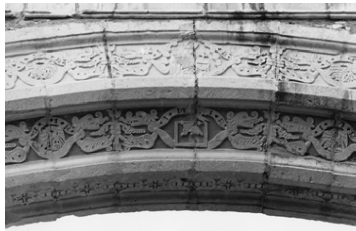
▲ Fig. 16 Dovelas recolocadas. COIXTLAHUACA_11A-1_1963-1969. XI-16-1-2. F. Palancares. Fototeca CNCPC | © INAH, 1964.
