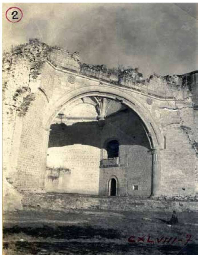
▲ Fig. 17 Aspecto de la capilla abierta antes de la restauración de 1957-1958. Aún no se había colocado el zuncho de concreto armado sobre el arco y aún quedaban estructuras que luego desaparecieron, como la que aparece al fondo en el interior o el murete del balcón de la sacristía adyacente. CLIII-89, V0A15TVII-B, CNMH | © INAH.
