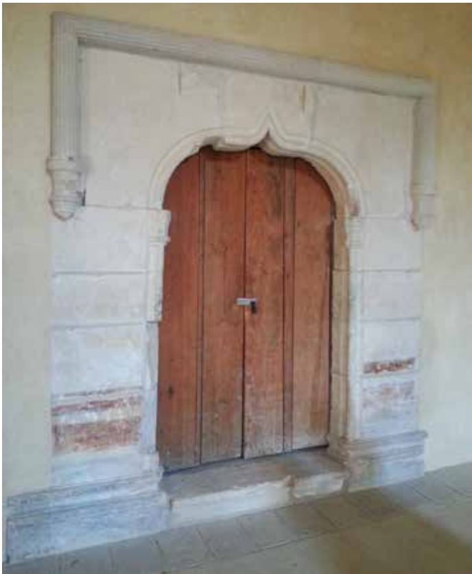
▲ Fig. 34 Acceso a la escalera tras la restauración. Fototeca CNCPC | © INAH, 2014.
