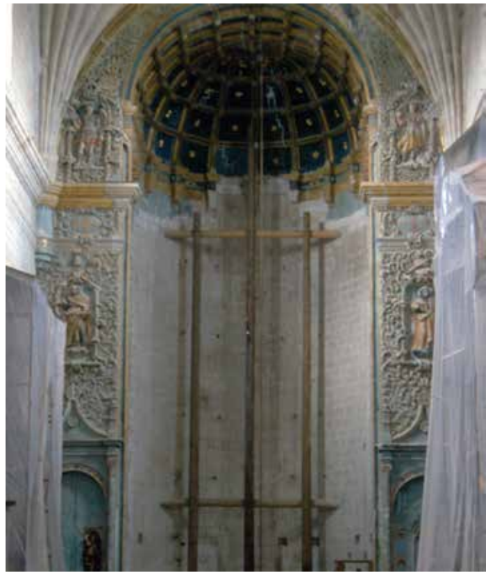
▲ Fig. 41 Estructura de soporte del retablo de Yanhuatlán. Fototeca CNCPC | © INAH, 2000.
