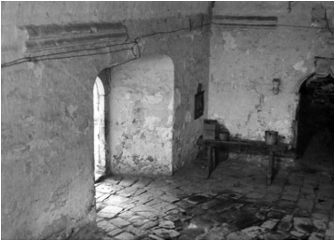
▲ Fig. 32 Acceso a la escalera antes de la restauración. COIXTLAHUACA_11A-4_1964-1969. X-20-3-6. Hacia 1964. Fototeca CNCPC | © INAH, 1964.
