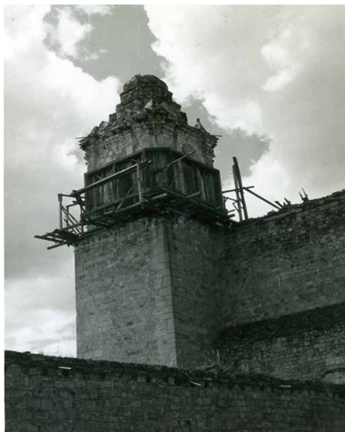
▲ Fig. 11 Estructura para montaje del zuncho. sn_folio122, V0A-15TVII-A, CNMH | © INAH.
