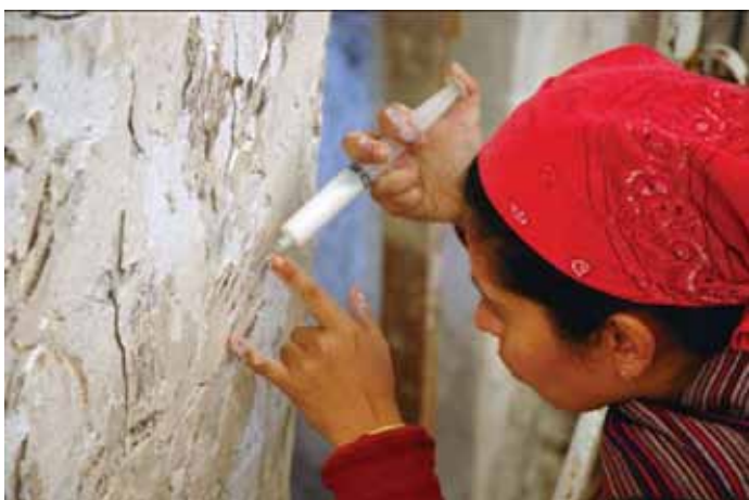
▲ Consolidación de pintura mural | © CNCPC-INAH, 2008
