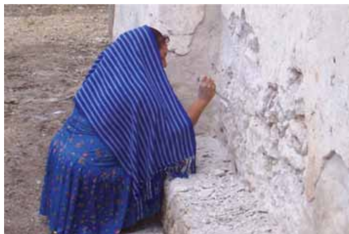
▲ Trabajos de conservación en fachada | © CNCPC-INAH, 2007
