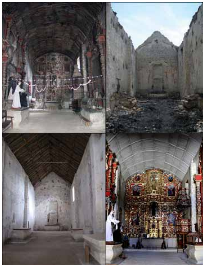
▼ Vista general de la nave del templo, antes y después de las intervenciones | © CNCPC-INAH, 2006, 2007, 2008 y 2013
