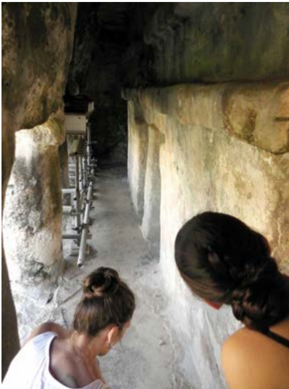
Figura 9. Pasillo frente al santuario del Edificio 16 de Tulum, mostrando un espacio reducido. Imagen: Jesús Antonio Muñoz Cinta, ©CNCPC-INAH, 2014.
