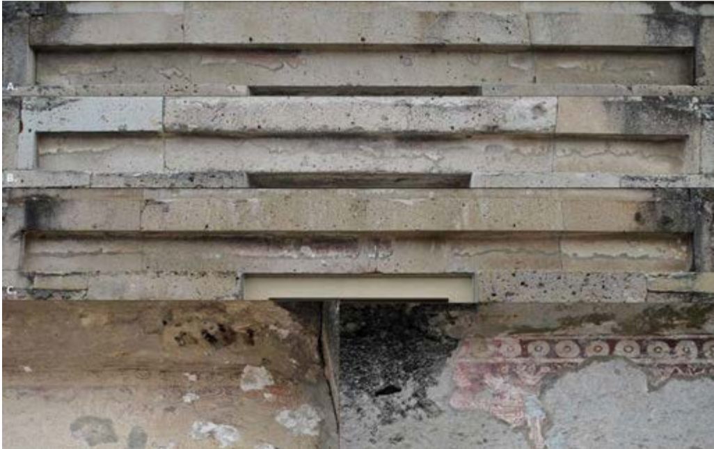
Figura 6. Patio A, Mitla. A. Foto general de la pintura mural en el dintel central del muro norte. B. Foto general de la pintura mural en el dintel central del muro poniente. C. Foto general de la pintura mural en el dintel central del muro este. D. Detalle de pintura mural muro norte. E. Detalle de pintura mural muro este. Imágenes: Gloria Martha Sánchez Valenzuela, 2011, ©CNCPC-INAH.
