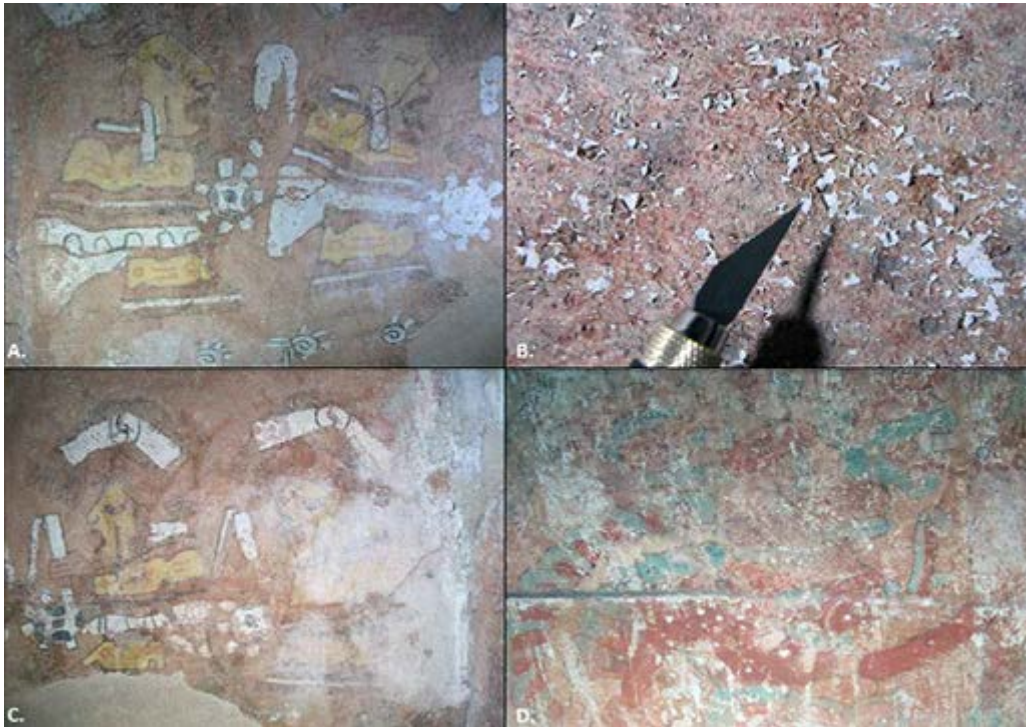
Figura 4. Tumba 1, Suchilquitongo. A. Grietas y fisuras generalizadas en la superficie de la pintura mural. B. Presencia de velos blancuecinos por presencia de sales. C. Desprendimiento de escamas de capa pictórica por presencia de polímeros. D. Abrasión y pérdida de capa pictórica generalizada. Imágenes: Gloria Martha Sánchez Valenzuela, 2011, ©CNCPC-INAH.
