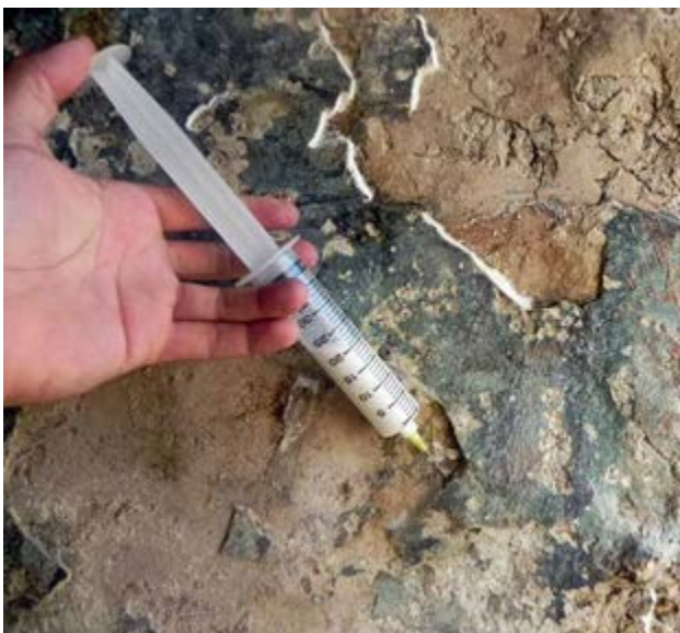
Figura 12. Estabilización de la pintura mediante la inyección de lechada en oquedades. Imagen: Mariana Díaz de León, 2016, ©CNCPC-INAH.
