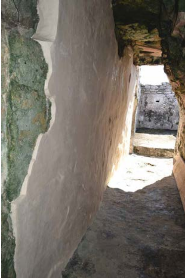
Figura 15. Fotografía que muestra el recubrimiento finalizado. Imagen: Gabriel Severiano, 2016, ©CNCPC-INAH.
