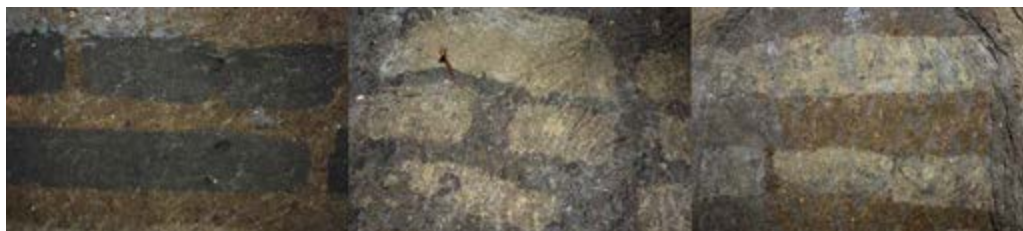
Figura 3. Comparativa de los tipos de adobe que se han identificado en las calas arqueológicas de la sección central de Los Bebedores , entre los muros 3 y 4. Imagen: Proyecto de conservación e investigación para las pinturas murales y otros acabados arquitectónicos de la zona arqueológica de Cholula, Puebla, ©CNCPC-INAH, 2016.
