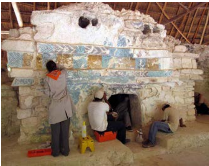
Figura 6. Durante los trabajos de conservación de la Estructura P1, Casa Azul, Calica, mediante proceso. Imagen: Mónica A. López Portillo Guzmán, 2016, ©CNCPC-INAH.
