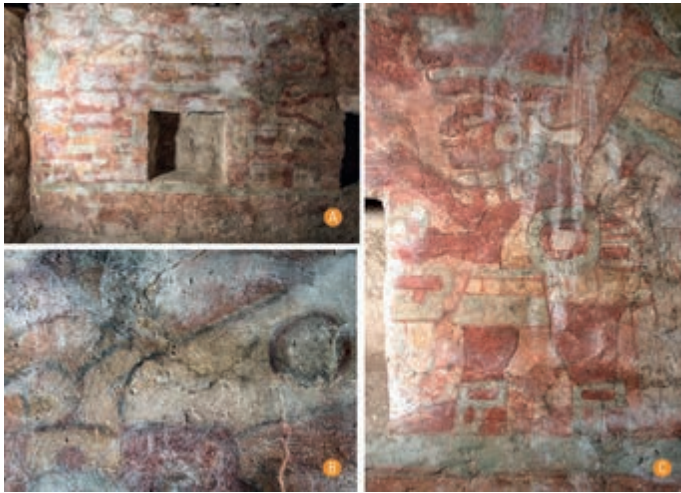
Figura 5. Tumba 104. A. Foto general del muro sur al interior de la cámara. B. Detalle de presencia de sales, muro sur. C. Detalle de presencia de sales y escurrimientos, muro norte. Imagen: Julio Martínez Bronimann, 2016, ©CNCPC-INAH.
