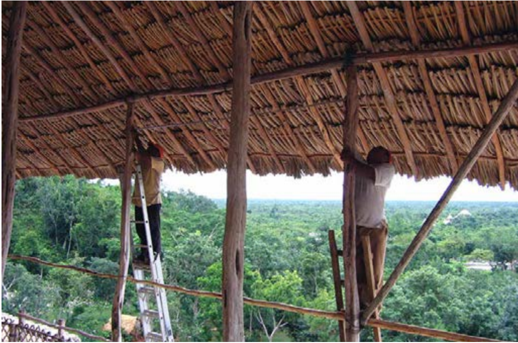
Figura 7. Trabajadores locales apoyando en la reparación de cubiertas de protección con materiales locales. Imagen: Proyecto de conservación 2013, ©CNCPC-INAH.
