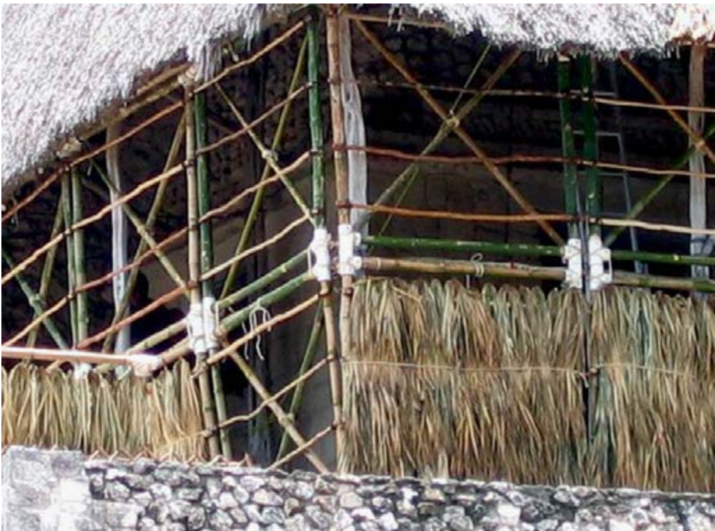
Figura 8. Trabajadores locales apoyando en la construcción de protecciones contra huracanes usando saberes tradicionales. Imagen: Proyecto de conservación 2013, ©CNCPC-INAH.
