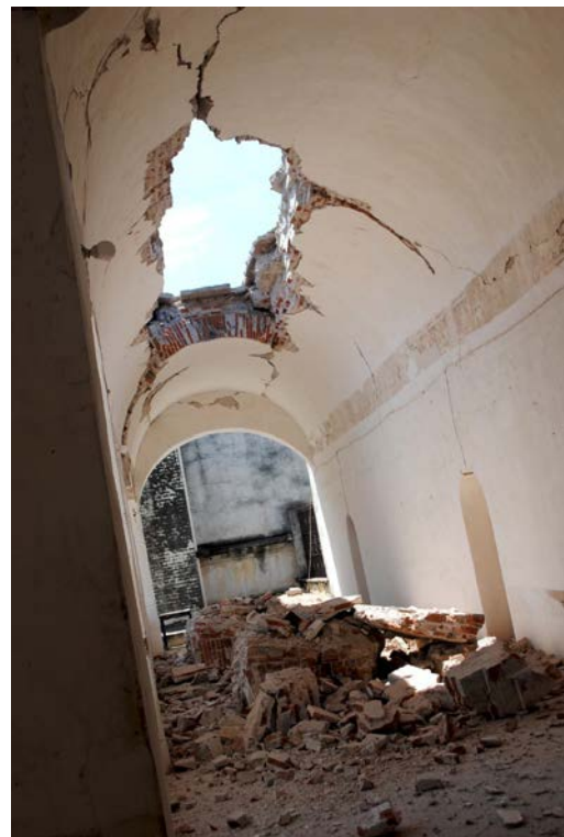
Figuras 2 y 3. Daños observados en la visita de inspección al exconvento de Santo Domingo, Tehuantepec, Oaxaca. A la izquierda, ala oeste del convento. A la derecha, colapso de bóveda en ala oeste, pasillo del 1er piso del convento. Imágenes: Thalía Velasco Castelán, ©CNCPC, 2017.
