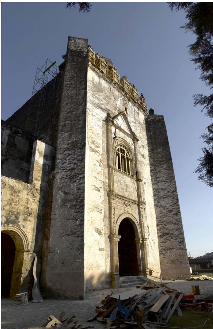
Figura 1. Templo del exconvento de San Juan Bautista Tlayacapan después de los trabajos de apuntalamiento. Imagen: Arturo Magdaleno Chapa, Posgrado en rehabilitación del patrimonio arquitectónico, ©UNAM, 2018.
