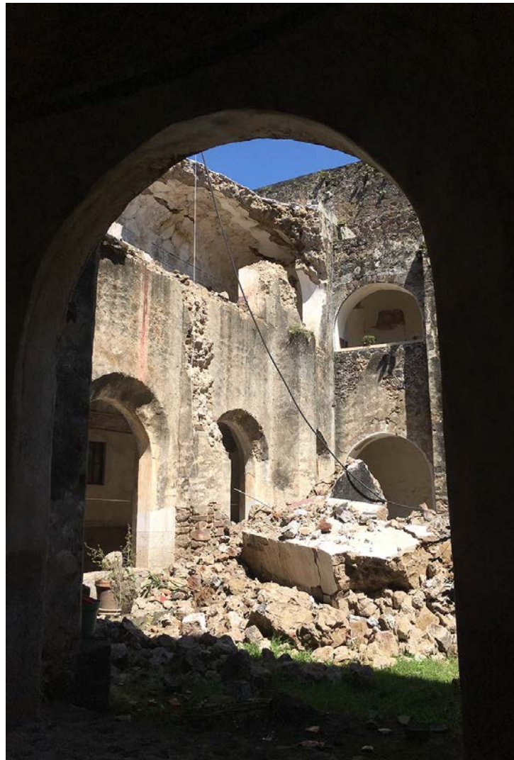
Figura 2. El claustro del exconvento de San Guillermo Totolapan después del sismo del 19 de septiembre de 2017. Imagen: Elsa Arroyo Lemus, ©IIE-UNAM, 2017.
