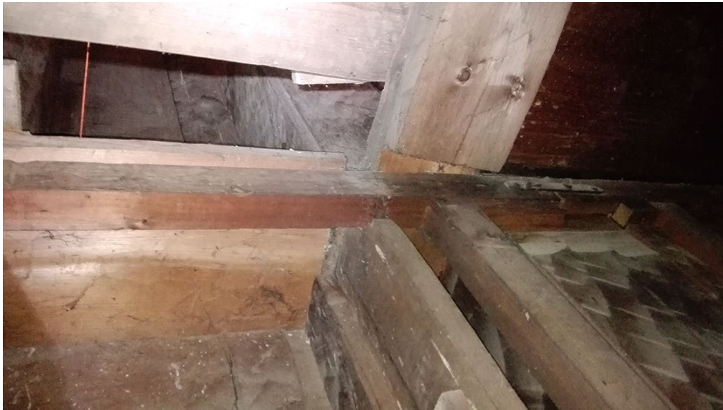
Figura 7. Se aprecia desajuste de tensor a la altura del segundo cuerpo del retablo principal de San Francisco en San Cristóbal de Las Casas, Chiapas. Imagen: ©Arturo Sebastián Casasola Busteros, 2017.
