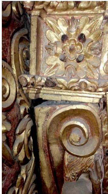
Figura 9. Detalle de desajuste en el cajón de entablamento del retablo de San José. Catedral de San Cristóbal de Las Casas, Chiapas. Imagen: ©Arturo Sebastián Casasola Busteros, CNCPC-INAH, 2017.
