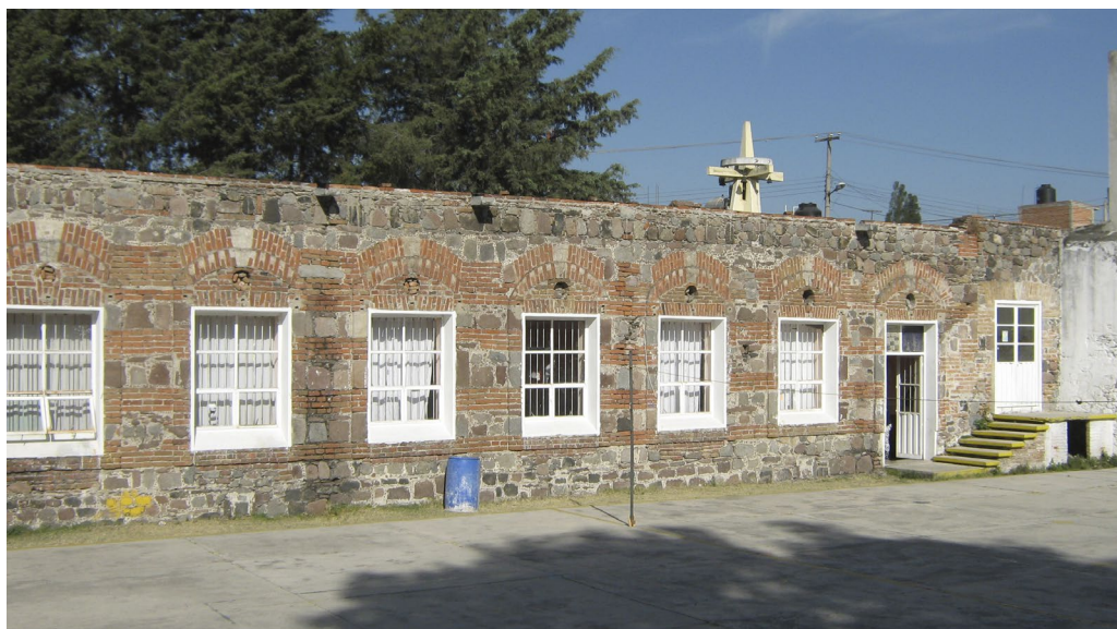
Figura 5. Edificio de la actual primaria Raúl Isidro Burgos. Imagen: ©Guillermo Aguado, 2015.
