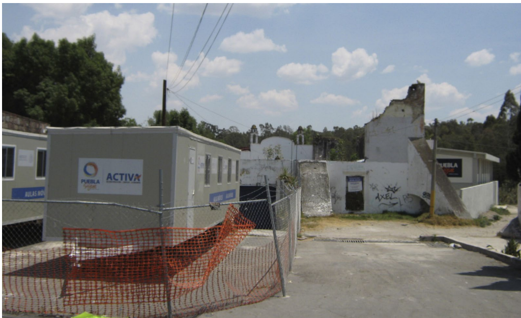
Figura 13. Frente de la telesecundaria con las aulas móviles que albergaron a los alumnos durante la construcción del edificio nuevo a un costado del inmueble histórico, en la imagen se observa del lado derecho al fondo. Imagen: ©Guillermo Aguado, 2019.
