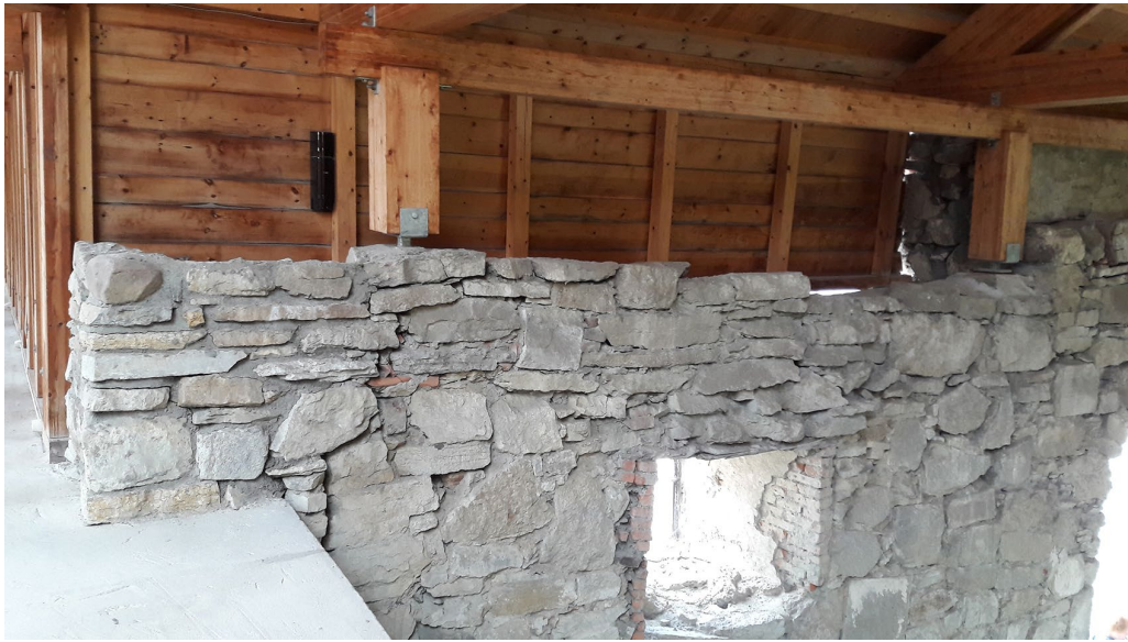
Figura 11. Fotografía de los muros de piedra existentes coronados y atados por un cordón perimetral de hormigón armado que aporta estabilidad y cohesión al estrato antiguo. Imagen: ©Iñigo Peñalba, 2016.
