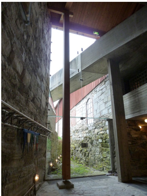
Figura 5. Fotografía de las planchas de vidrio en su encuentro con los muros existentes y la rampa de hormigón armado, que atraviesa el vacío del paño vertical. Imagen: ©Iñigo Peñalba, 2016.
