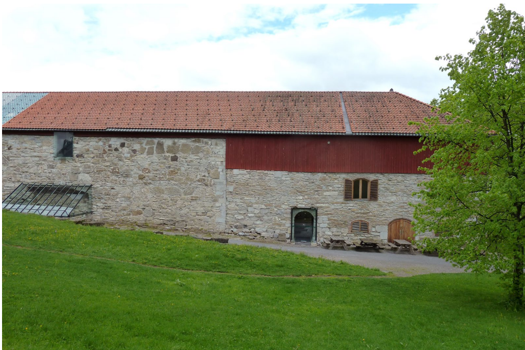
Figura 8. Parte del alzado oeste, se aprecia el corte que existe entre el muro antiguo de la fortaleza del obispo (a la izquierda) y el granero del siglo XVIII (a la derecha). Imagen: © Iñigo Peñalba, 2016.
