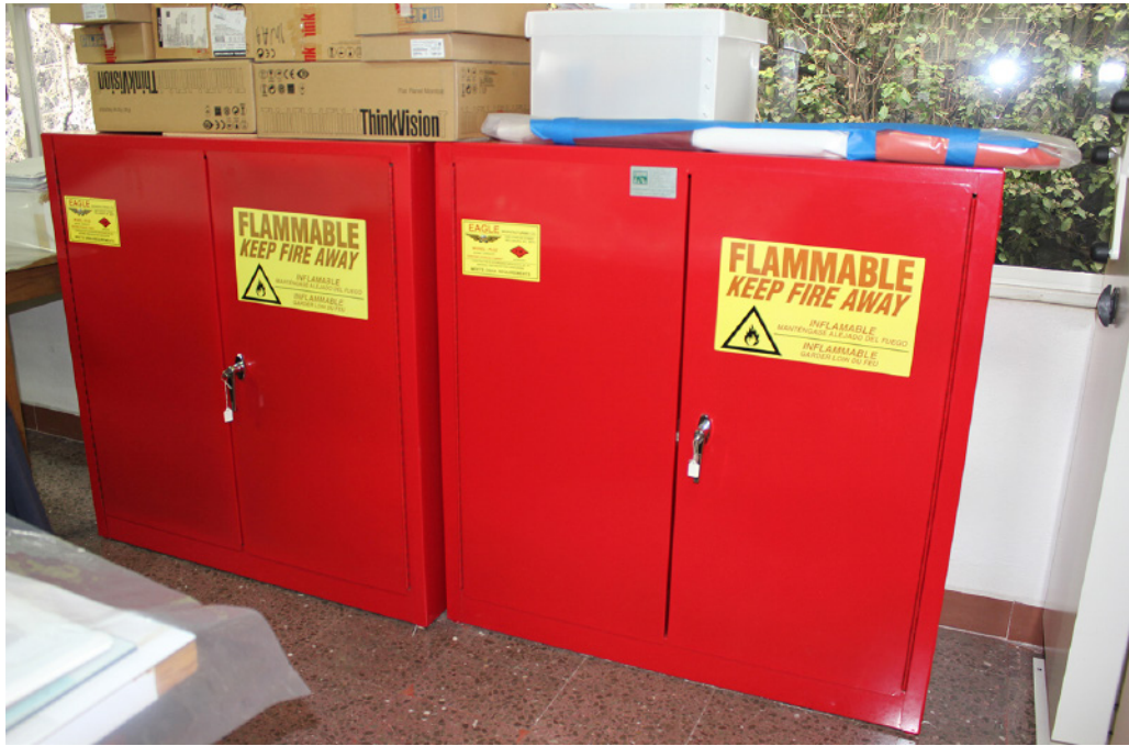
Estantes especiales para guardar sustancias peligrosas. Imagen: ©María Bertha Peña Tenorio.
