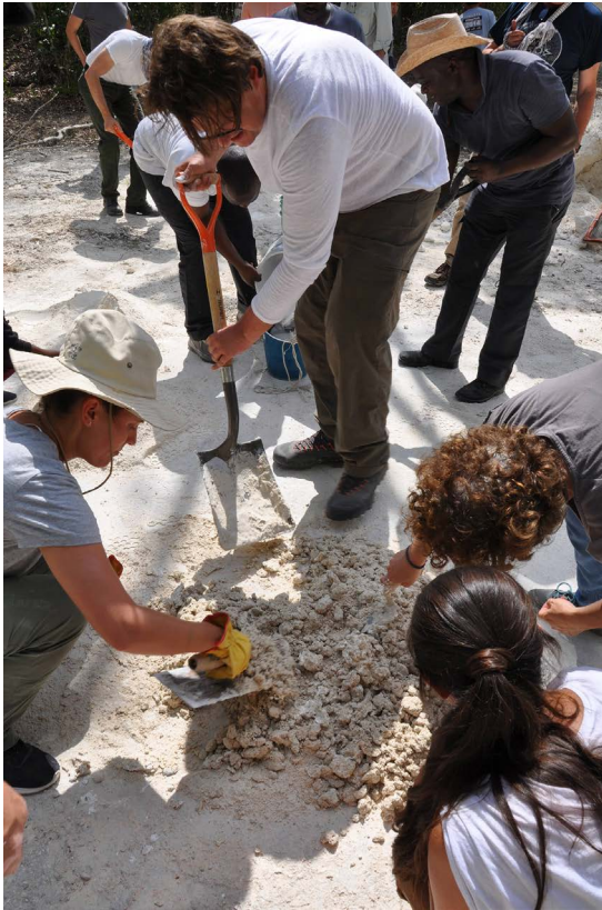
Figura 6. Preparación de Mortero para intervención directa en el sitio arqueológico de Chicanná. Imagen: ©Valerie Magar.
