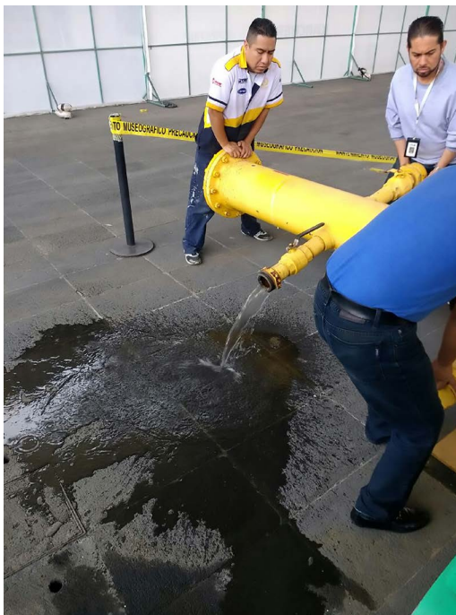
Figura 6. Limpieza del cabezal del compresor de aire. Imagen: Montserrat Torres ©MNA-INAH, 2018.
