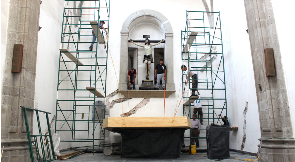
Encofrado de cristo. Templo de la Expiración. Centro Histórico de la Ciudad de México. Imagen: Oscar Adrián Gutiérrez Vargas. @CNCPC-INAH, 2019.
