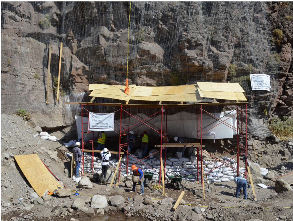
Figura 2. Trabajos de liberación y estabilización del abrigo con pinturas rupestres, sitio Cuevas Pintas. Imagen: ©Programa Nacional de Conservación de Patrimonio Gráfico Rupestre, CNCPC- INAH, 2016.
