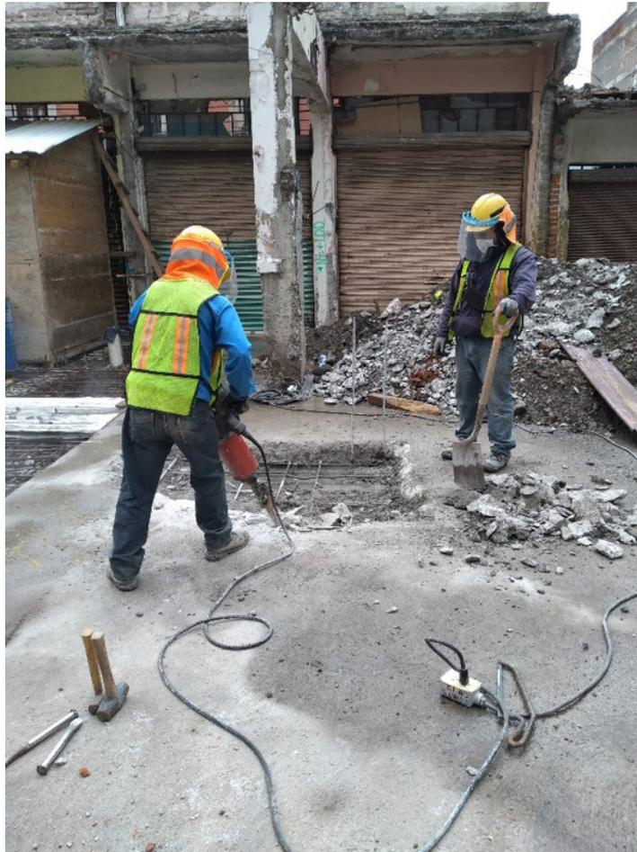
Figura 4. Inicio de excavación de un área de  $2 \times 2$  de acuerdo con los lineamientos generales descritos: sana distancia y equipo de protección personal. Imagen: ©Juan Carlos Campos, 2020.
