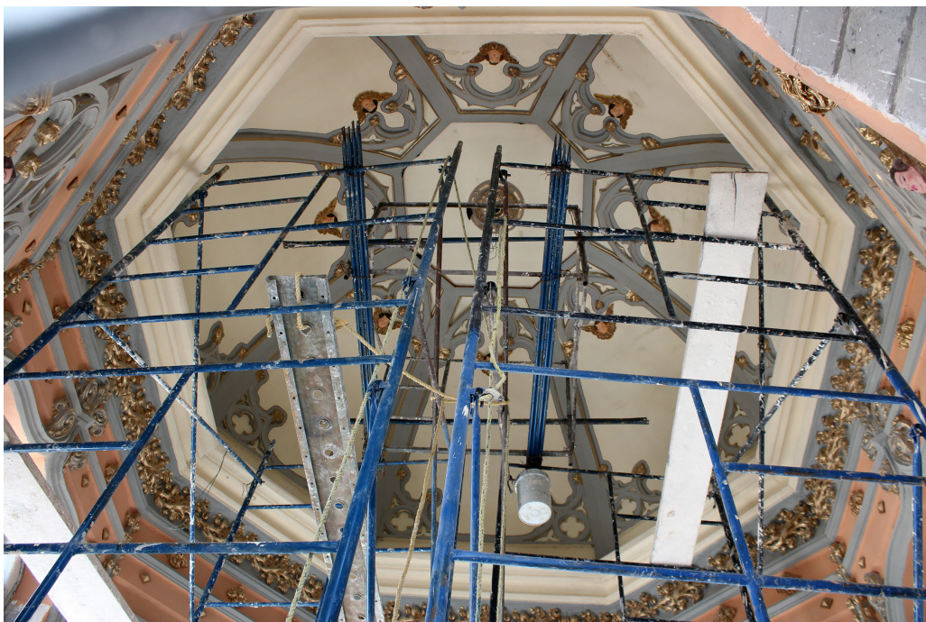
Figura 10. Presencia de andamiaje en interior del mausoleo Bello, con el propósito de efectuar tareas de mantenimiento. Imagen: ©Luis Eduardo Gutiérrez García, 2021.
