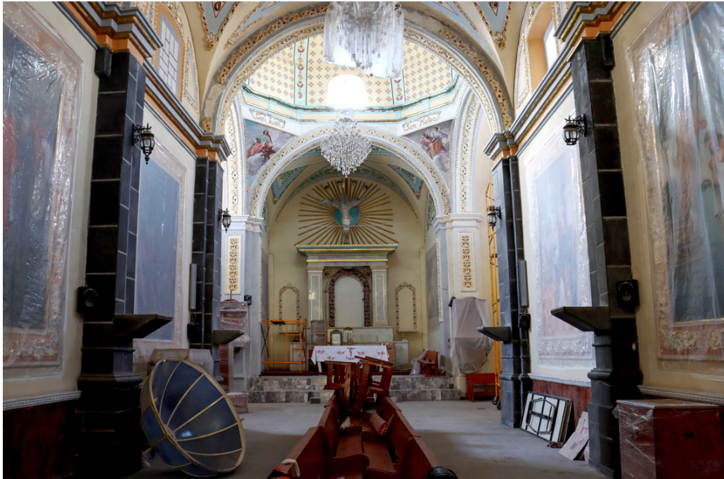
Figura 1. Interior del templo con protecciones. Imagen: ©CNCPC-INAH, 2021.
